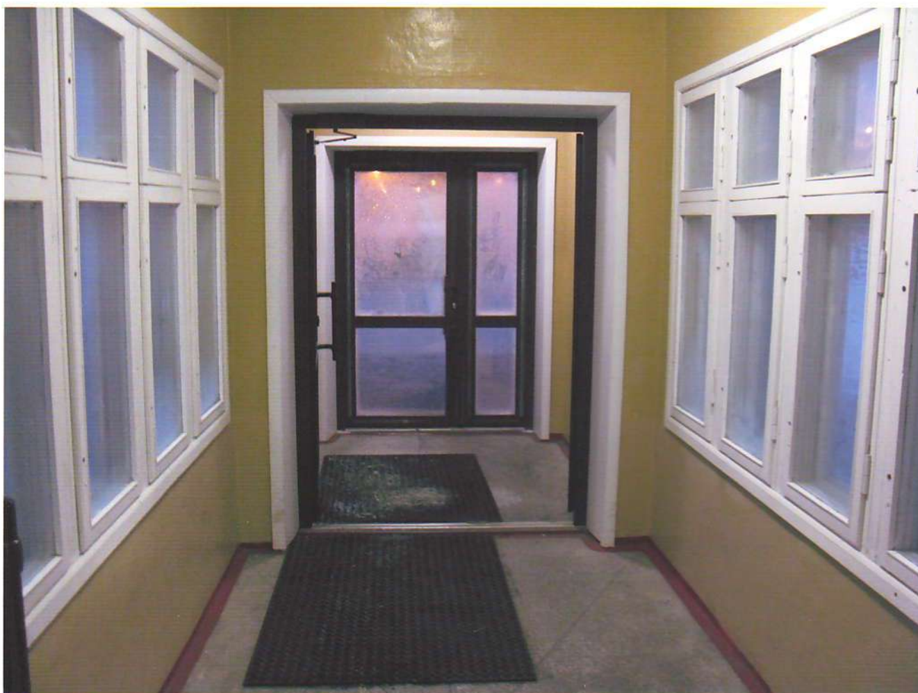
Фото №2. Входной тамбур.
